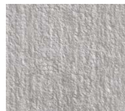
CSP 4 – Escarificación (fresa) leve 1270 µm*
